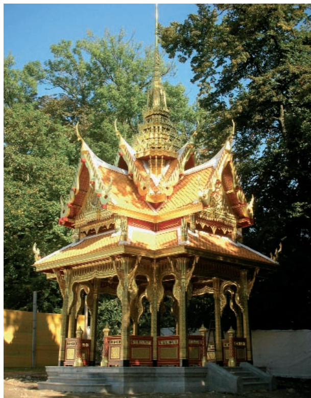
Cadeau de la Thaïlande à la Ville de Lausanne, où le roi a vécu et étudié, le petit édifice décoratif en bois peint, haut de 16 m, est ouvert au public depuis le 29 septembre. En accès libre dans la partie nord-ouest du parc Denantou, il accueille Lausannois et hôtes de passage.
